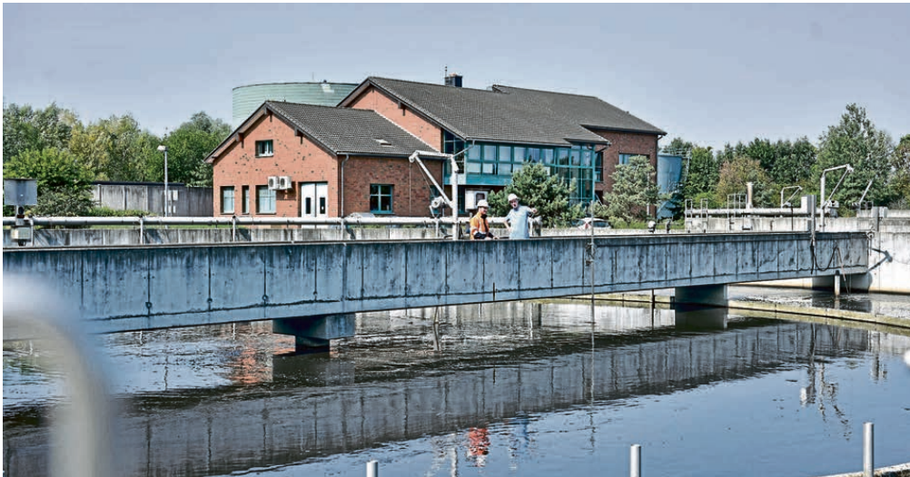
Die Kläranlage Schönebeck (Elbe): einst einer der größten Energieverbraucher in der Stadt – heute energieautark.
