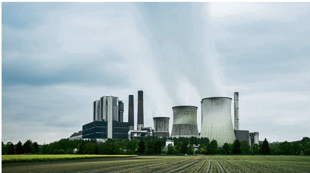
Das Braunkohle-Kraftwerk Weisweiler der REW in Eschweiler: eine Technik, die absehbar zu Ende geht. Die Stadt muss sich darauf einstellen.
