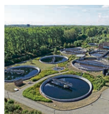
Blick aus der Vogelperspektive auf eine der größten Kläranlagen Sachsen-Anhalts.
