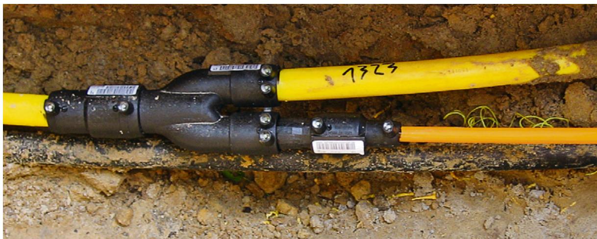
Eine Gasleitung mit eingeführtem Glasfaserkabel: Es gibt Alternativen zum klassischen Netzausbau der Telekom.
